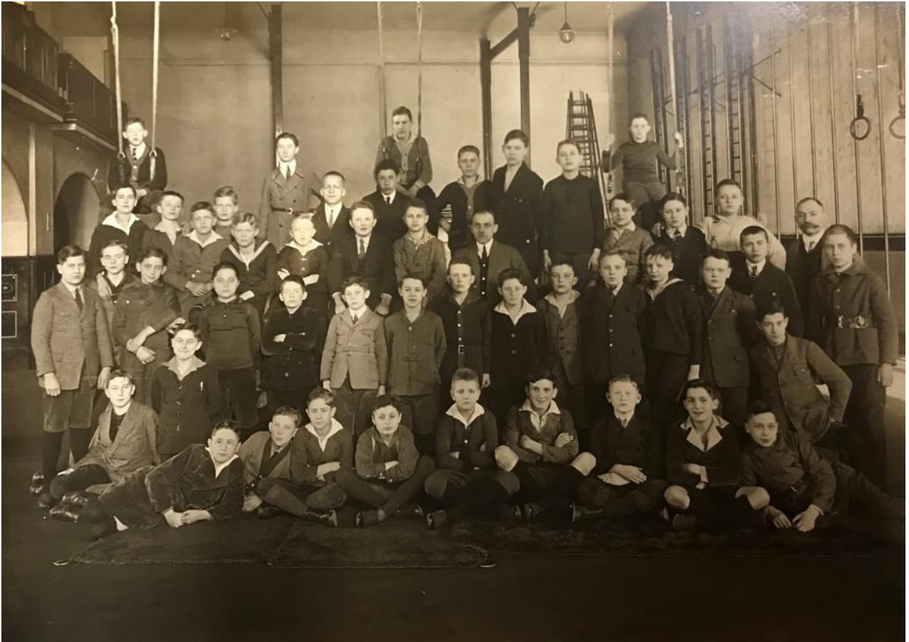
Turnhalle der Helmholtzschule, zu erkennen sind die Geräte Ringe, Stangen, Sprossenwand und Leitern.
