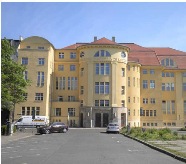
Die 1913 erbaute Turnhalle Leplaystraße nach der Sanierung 2011. Foto Sportmuseum Leipzig
