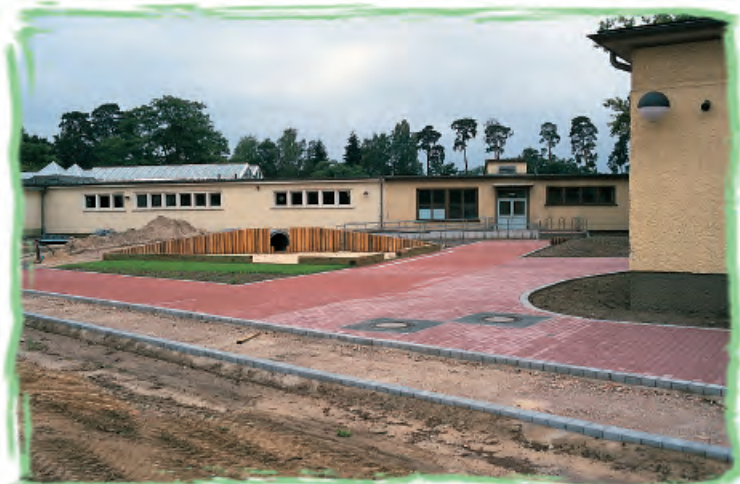
Umbaumaßnahmen im Herbst 2000
